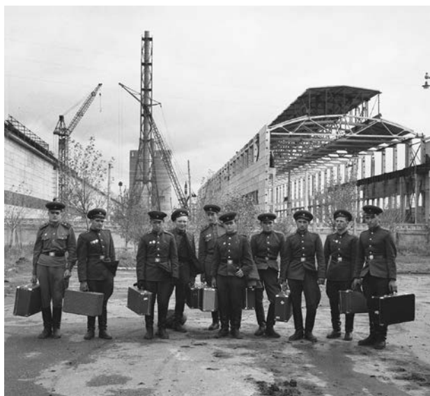
Первым поколением металлургов стали пограничники, которые прибыли на строительство завода по комсомольским путевкам. Сейчас уже трудно поверить, что полвека назад КрАЗ выглядел именно так. Фото из архива редакции газеты «Вестник РУСАЛа»
